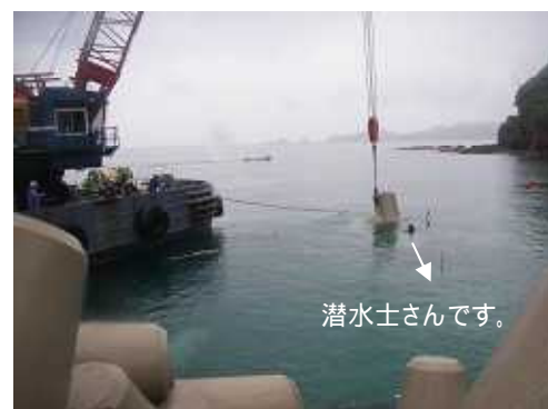
ブロック据付状況 起重機船と潜水士とでブロックを海へ据え付けます。
