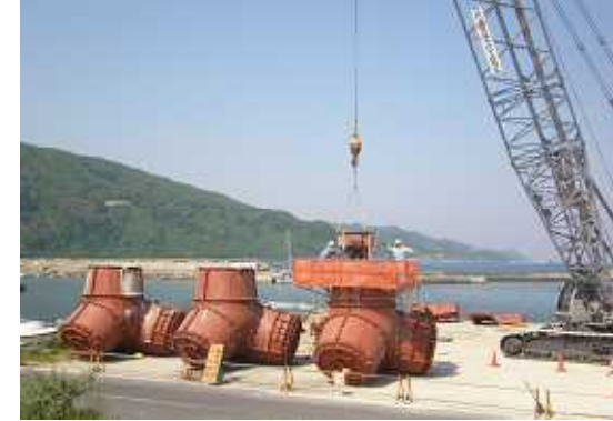
消波ブロック打設状況 鋼製の型枠を組立て、クレーン(150t吊)でコンクリートを流し込みます。
