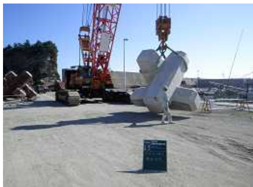
ブロック転置状況 コンクリートの強度が出たら、型枠を取り外し船に積み込み出来るよう動かします。
