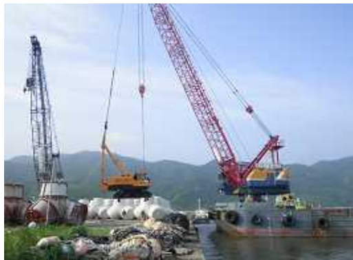
クローラークレーン海上運搬状況 消波ブロック製作に使用するクローラークレーンは起重機船にて海上運搬しています。
