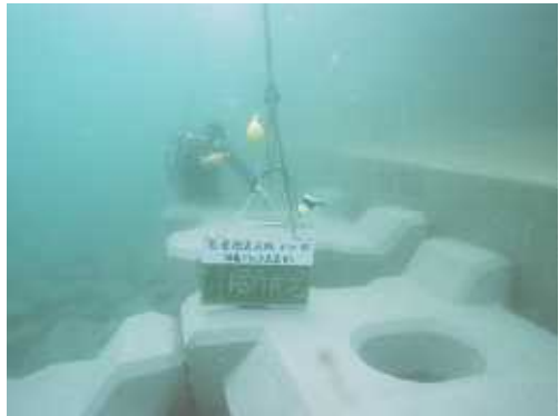
ブロック据付作業 ブロックを水中ですえつけている作業です。潜水士さんは無線を持って陸上の仲間と連絡を取っています。
