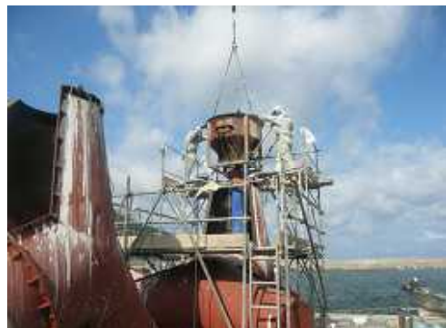
ブロック製作状況 鋼製の型枠を組立て、クレーンで コンクリートを流し込みます。
