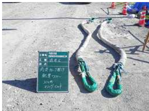
ブロック転置状況 ブロック転置にはスリングベルト（布製帯）を使用し、消波ブロックに傷をつけないよう配慮しています。
