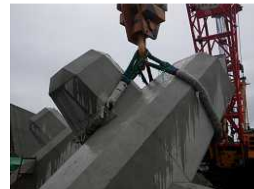
ブロック転置状況 ブロック転置にはスリングベルト（布製帯）を使用し、消波ブロックに傷をつけないよう配慮しています。
