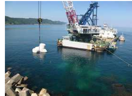
消波ブロック据付状況 起重機船(350t吊)と潜水士とで消波ブロックを水中へ据付ます。
