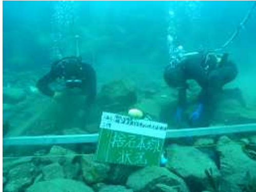
捨石均し作業 海の中で捨石と呼ばれる、構造物の基礎となる石を潜水士さんの手できれいに並べています。
