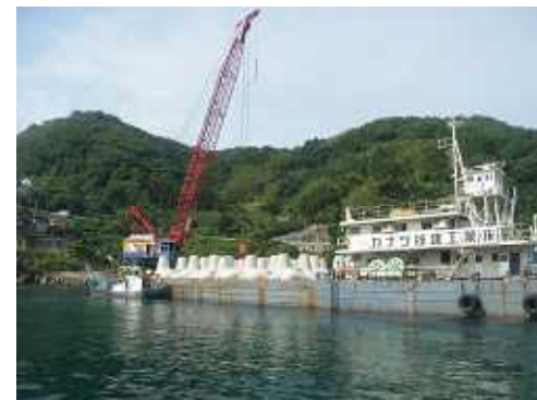
ブロック運搬状況 起重機船でブロックを運搬しま す。
