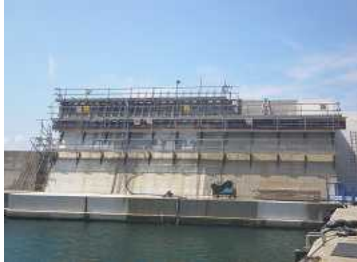
上部コンクリート工 施工延長 L=20m、作業用足場を確実に設置し、安全に作業をしています。
