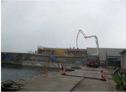
上部コンクリート工 コンクリートポンプ車により打設作業を行います。
