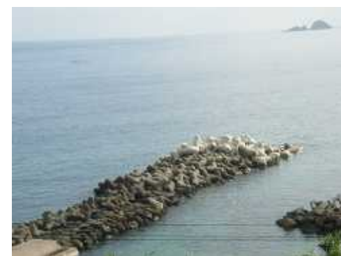
ブロック据付完了 白いところが、今回新しくすえつけた場所 です。
