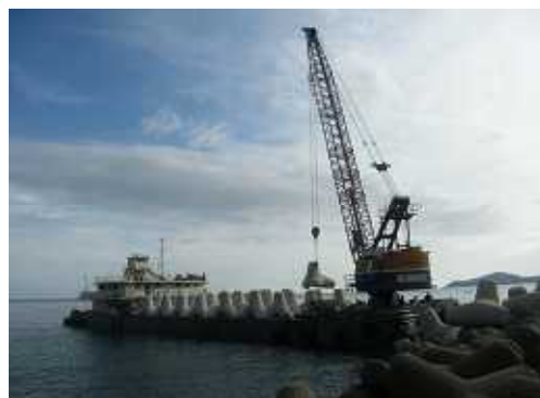
ブロック据付状況 起重機船と潜水士とでブロックを海へ据え付けます。
