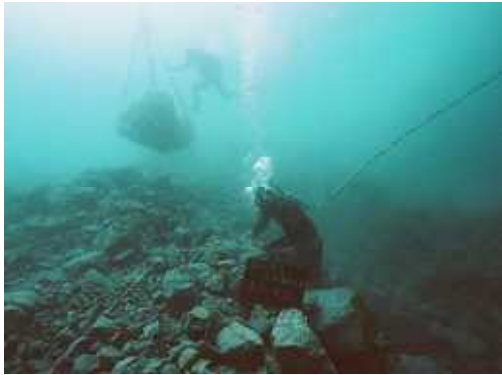
捨石均し作業 海の中で捨石と呼ばれる、構造物の基礎となる石を潜水士さんの手できれいに並べています。
