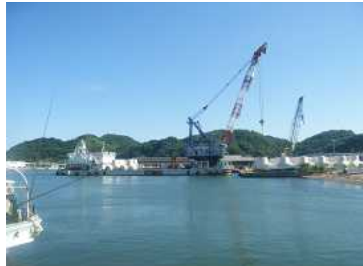
消波ブロック積込状況 起重機船(350t吊)にて消波ブロックを積み込みます。
