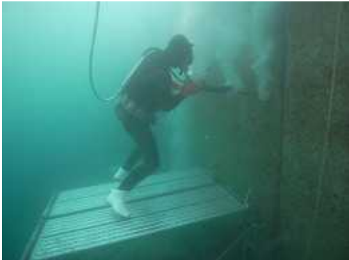
ハツリ作業 海の中でコンクリートに穴を開けています。空気力で動く機械を使っているため海中でも作業できるのです。
