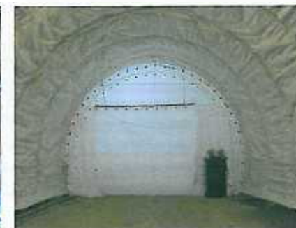
覆工コンクリート完了
