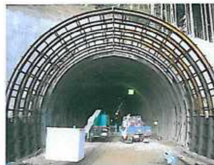
終点側明り部施工
