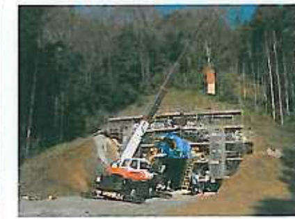
坑門型枠工
