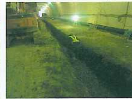
配水管布設状況
