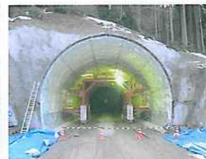
終点側明り部施工
