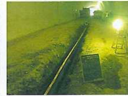
配水管設置完了
