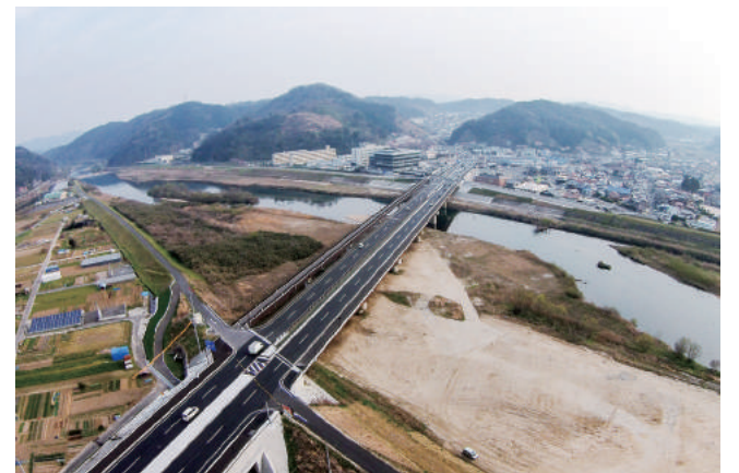
三澤さんが担当した国道54号線里熊大橋床版工事は、国土交通省中国地方整備局の局長表彰を受賞した。
