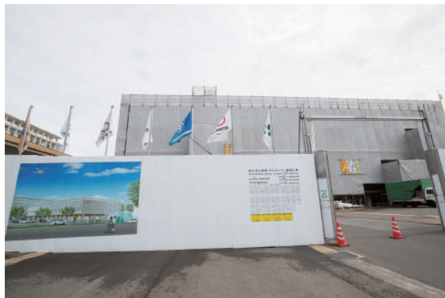
山陰初の放射線治療機械が導入される松江市立病院がんセンターの工事現場。
