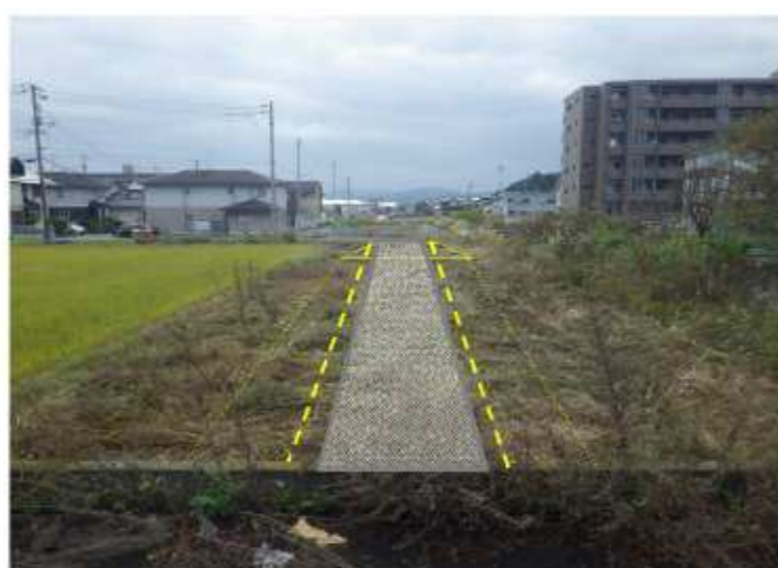
盛土を行い、敷砂利を行います。
