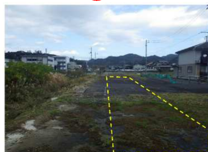
既設舗装版を使用し工事車両を通行させます。
